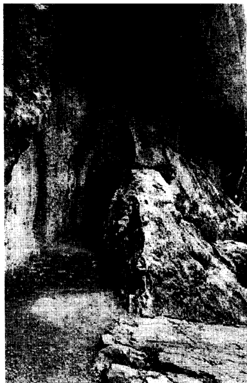
Figura 6 Canal y galería excavados en la roca
