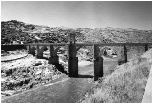
Figura 1 Vista del puente de Alcántara
